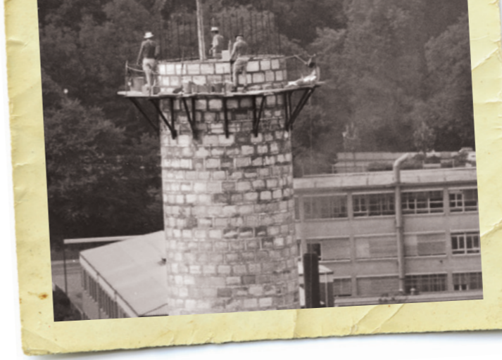
1970 wurde mit dem Bau der Kuppelhalle und des neuen Schornsteins begonnen.
