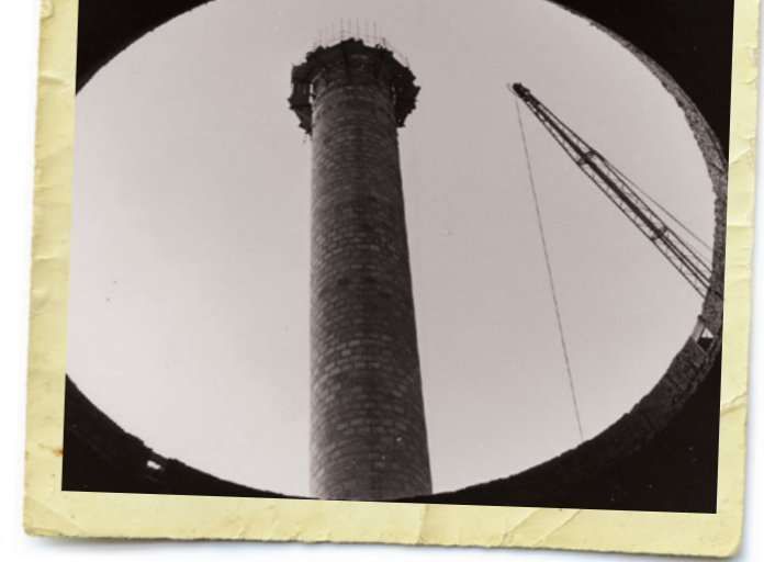
Blick durch die Lichtkuppel auf den neuen Schornstein im Jahr 1970.
