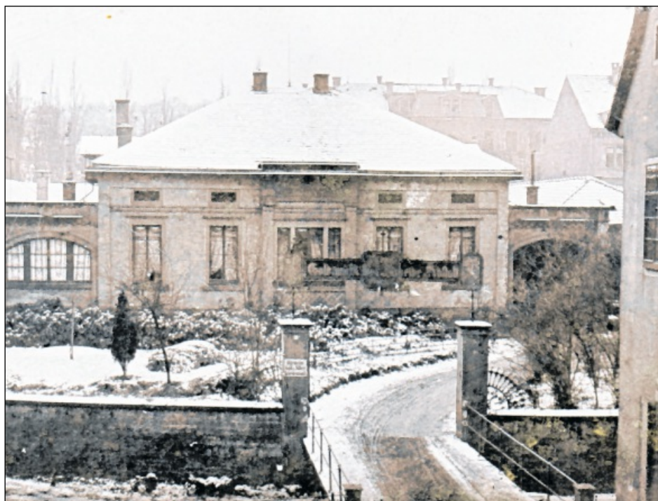
EIN GRÜNDERZEITBAU war bis Kriegsende der Stammsitz der Agosi am Altstädter Kirchenweg. Nach der Zerstörung fand an der Stelle die Alfons-Kern-Schule Platz.
